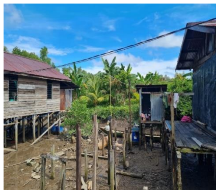
Gambar 22. Observasi Konstruksi Bangunan Jamban
