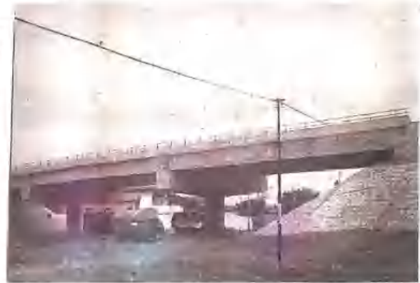
Jalan Layang Tol Ujungpandang (sisi bagian bawahnya tetap menjadi jalan umum biasa. (Iskandar)
