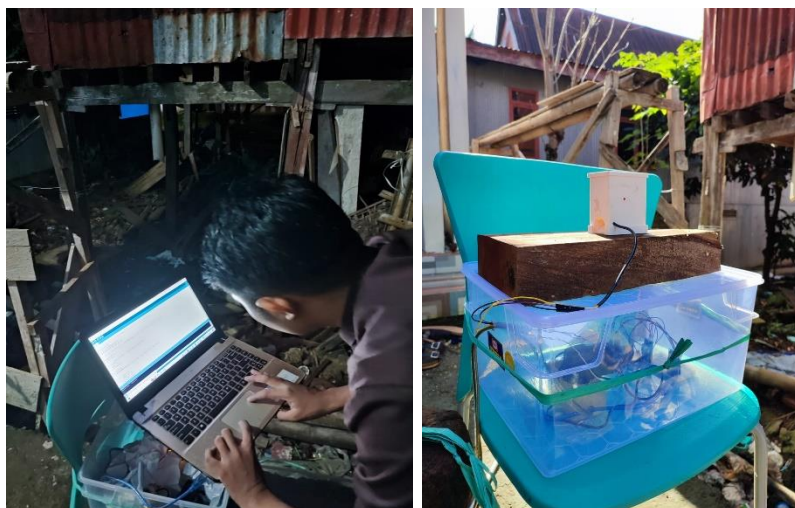
Gambar 37. Pemasangan sensor curah hujan.
