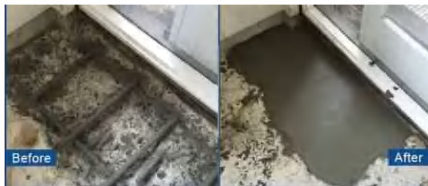
Gambar 3. Grouting pada beton bertulang
