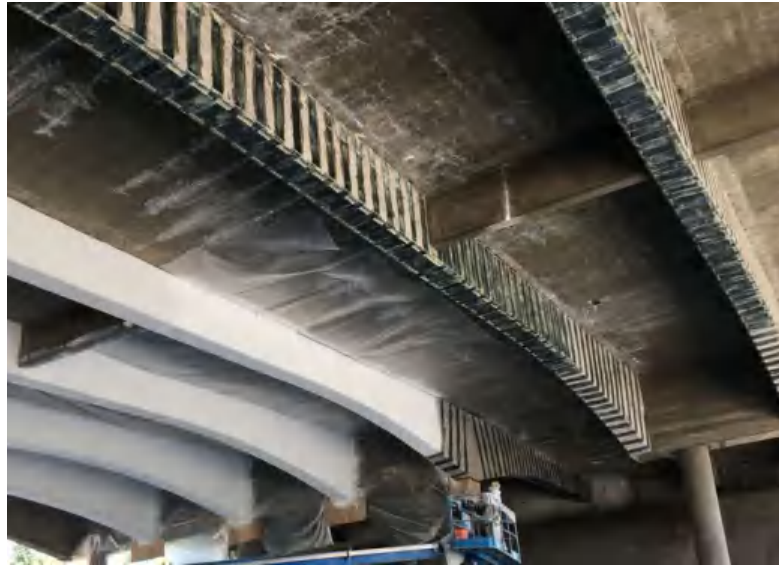
Gambar 9. Penggunaan FRP sebagai perkuatan pada girder jembatan
