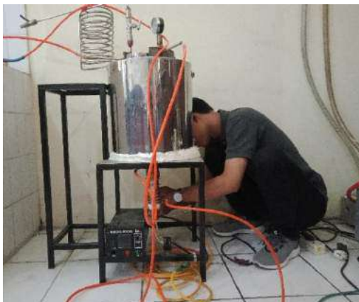
Pemasangan komponen alat CVD
