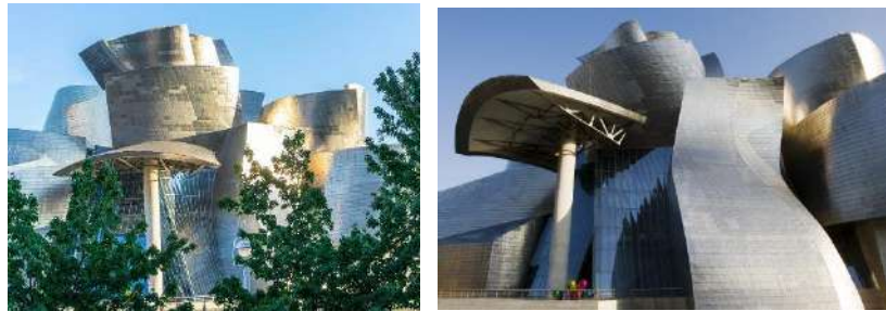
Gambar 2.98 Eksterior bangunan Guggenheim Museum
