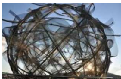
Gambar 2.87 Struktur baja “Medusa” pada atap The Dancing House Sumber: Buku Arsitektur Dekonstruktivis, 2019
