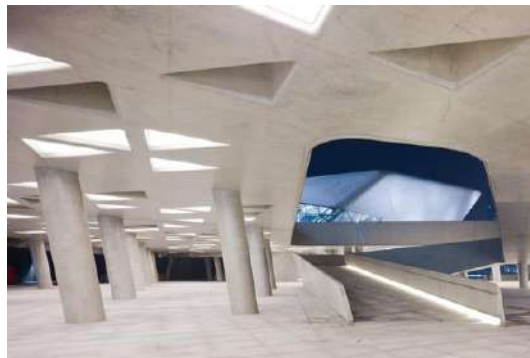
Gambar 2.150 Area masuk ke dalam bangunan Guangzhou Opera House
