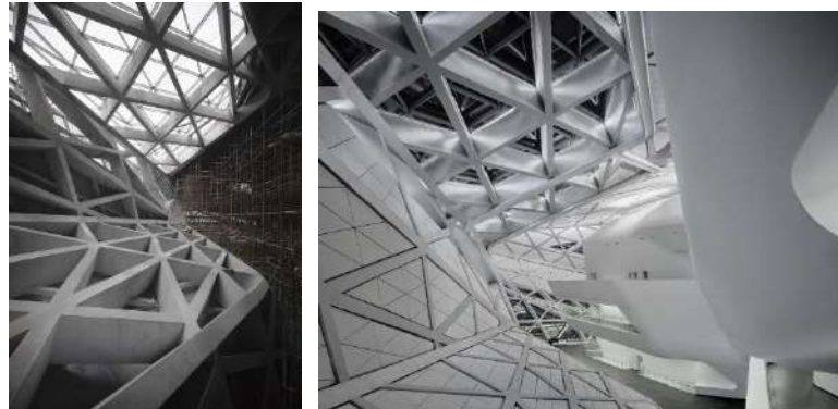
Gambar 2.156 Detail struktur penggunaan baja cor bangunan
