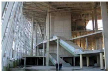
Gambar 2.144 Detail struktur interior salah satu bangunan The City of Culture Sumber: Buku Arsitektur Dekonstruktivis, 2019
