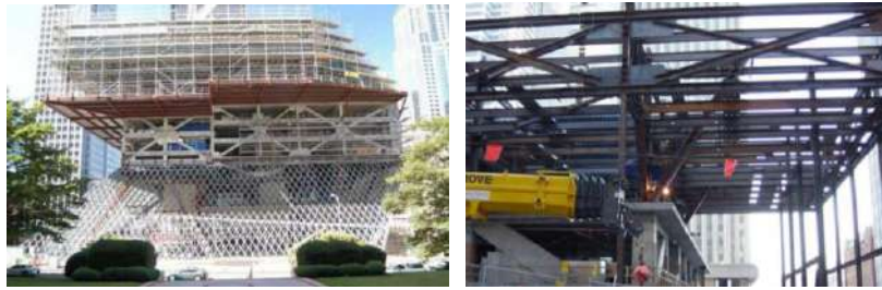
Gambar 2.125 Progres konstruksi Seattle Public Library Sumber: Buku Arsitektur Dekonstruktivis, 2019
