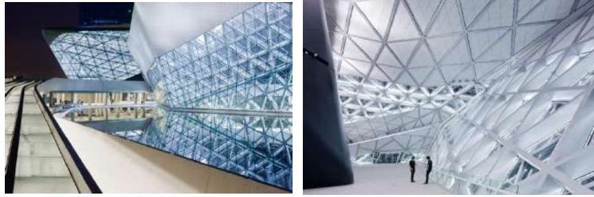
Gambar 2.151 Penggunaan kaca yang terbuka, dilapisi dengan rangka baja Sumber: https://www.archdaily.com/115949/guangzhou-opera-house-zaha-hadid-architects
