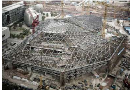
Gambar 2.157 Progres Konstruksi Guangzhou Opera House
