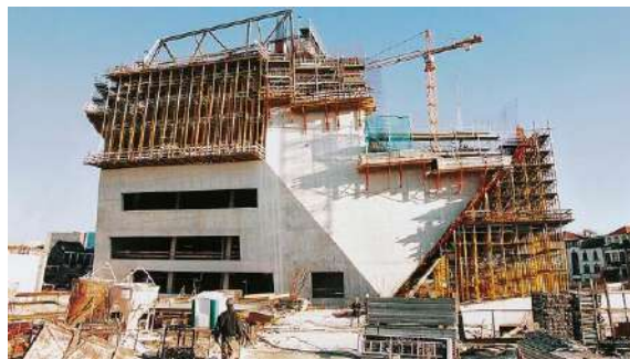
Gambar 2.121 Progres Konstruksi Casa Da Musica Sumber: Buku Arsitektur Dekonstruktivis, 2019
