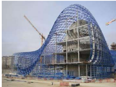
Gambar 2.180 Progras konstruksi bangunan Heydar Aliyev Centre
