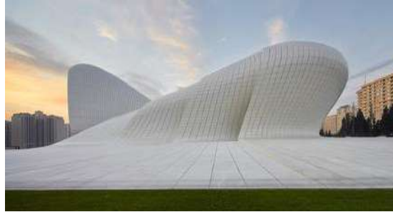
Gambar 2.165 Tampilan fasad bagian kiri bangunan dengan kesan cair
