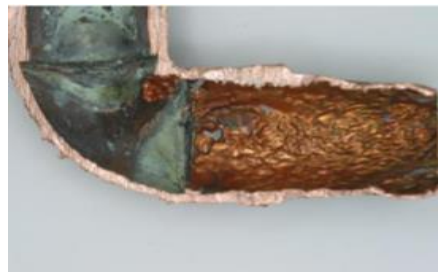
Gambar 7. Korosi erosi (Utomo, 2009)
