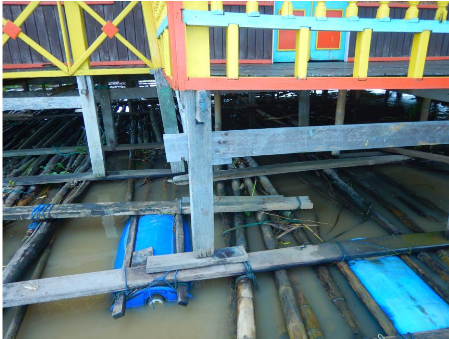
Gambar 2.10 Bentuk rumah apung dan struktur bawah yang ada di Danau Tempe milik Dinas Pariwisata (Penulis, 2020)
