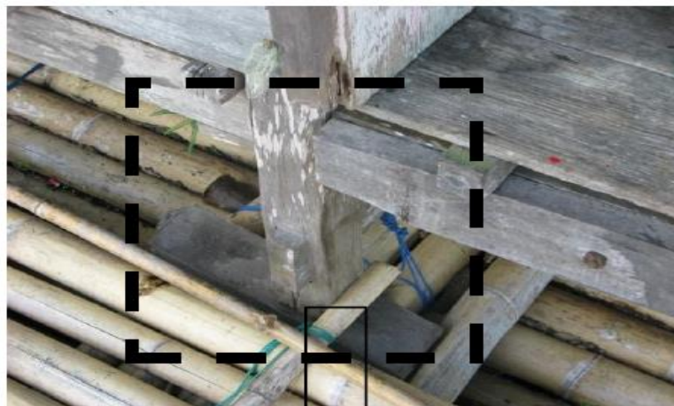
Gambar 2.21 Struktur bawah rumah Apung (Naing, 2013)
