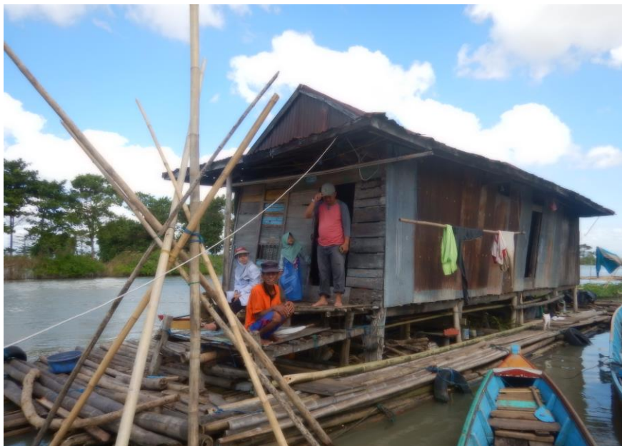
Gambar 2.9 Bentuk rumah apung dan struktur bawah yang ada di Danau Tempe milik warga nelayan (Penulis, 2020)
