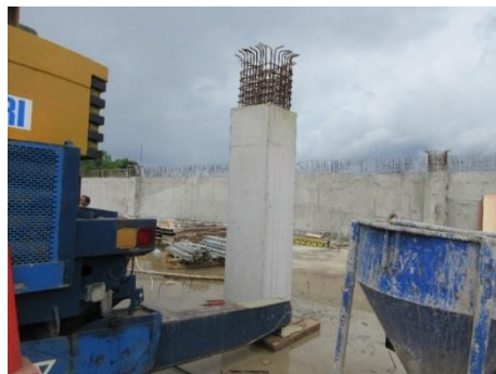
Gambar 5. Kolom yang Telah Jadi
