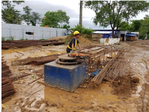
Gambar 2. Mesin Pembengkok dan PemotongTulangan
