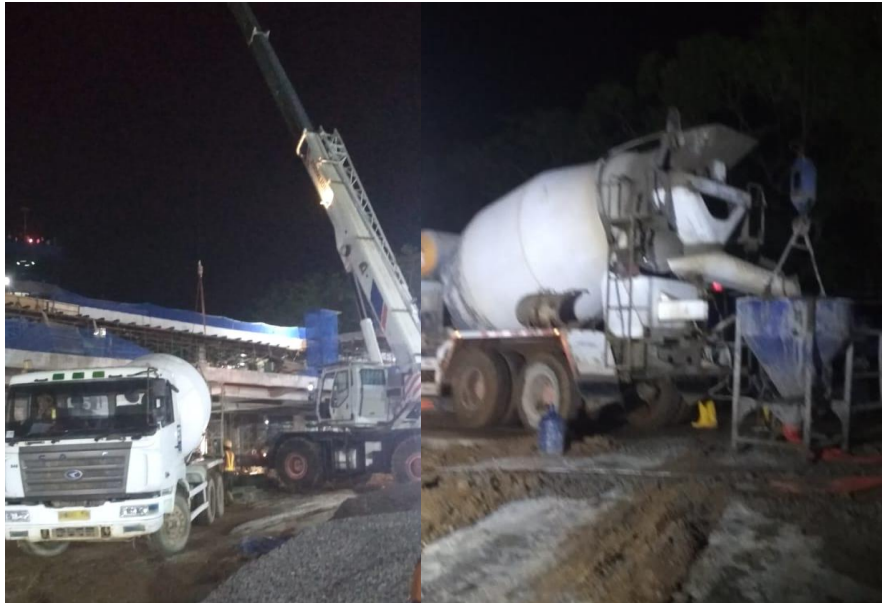
Gambar 4. Pengecoran Kolom Dengan Concrete Pump dan Bucket
