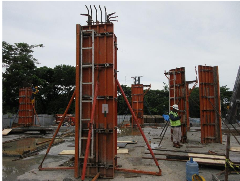
Gambar 3. Bekisting Kolom
