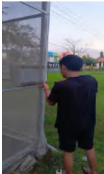
Lampiran 3. Pemasangan box panel alat sistem kendali pada greenhouse
