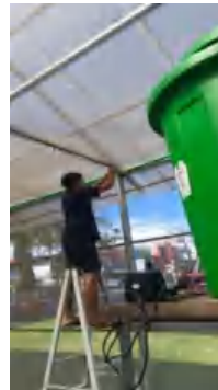
Lampiran 4. pemasangan instalasi air
