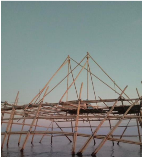
Bagan tampak samping
