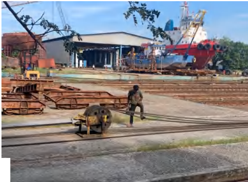
Pengaturan tali sling di slipway dock dimana pekerja tidak menggunakan APD
