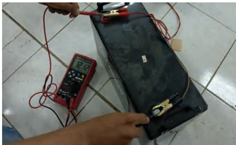
Gambar 5 Tegangan pada system pendingin 12.12 Volt
