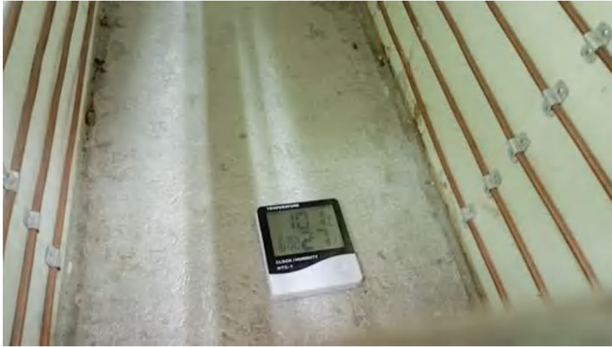
Gambar L.5 Suhu pada system pendingin 10,1°C
