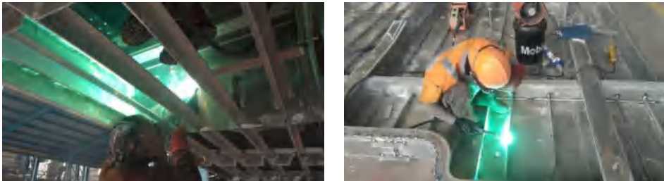
Gambar 35. Pengukuran Data Produktifitas Juru Las
