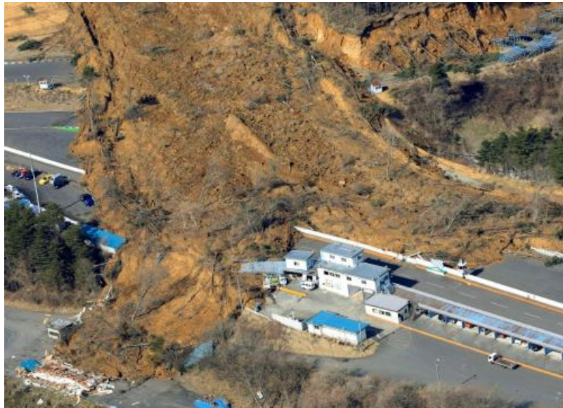
Gambar 2 Keruntuhan jalan akibat Gempa di Jepang
