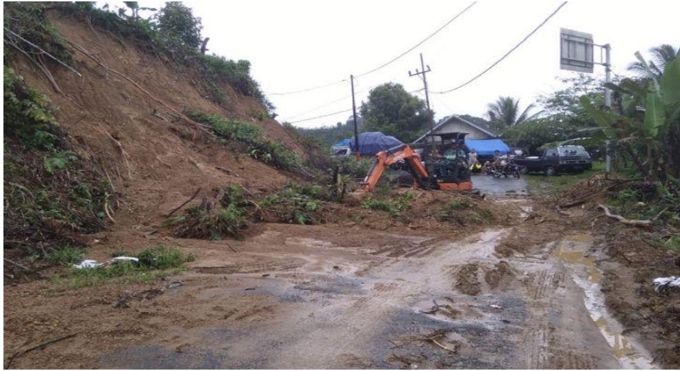
Gambar 1 Keruntuhan Lereng
