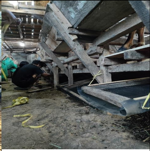
Pemasangan penampung Feses
