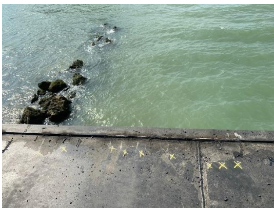
Gambar 6. Pemberian tanda titik kebocoran
