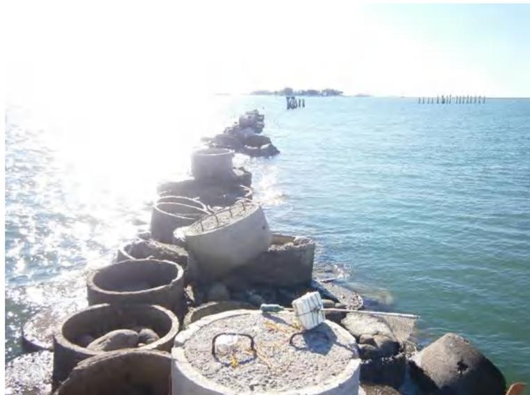
Gambar 1.1. Pemecah gelombang dari silinder-silinder beton di suatu lokasi di pantai Tanjung Bunga, Makassar
