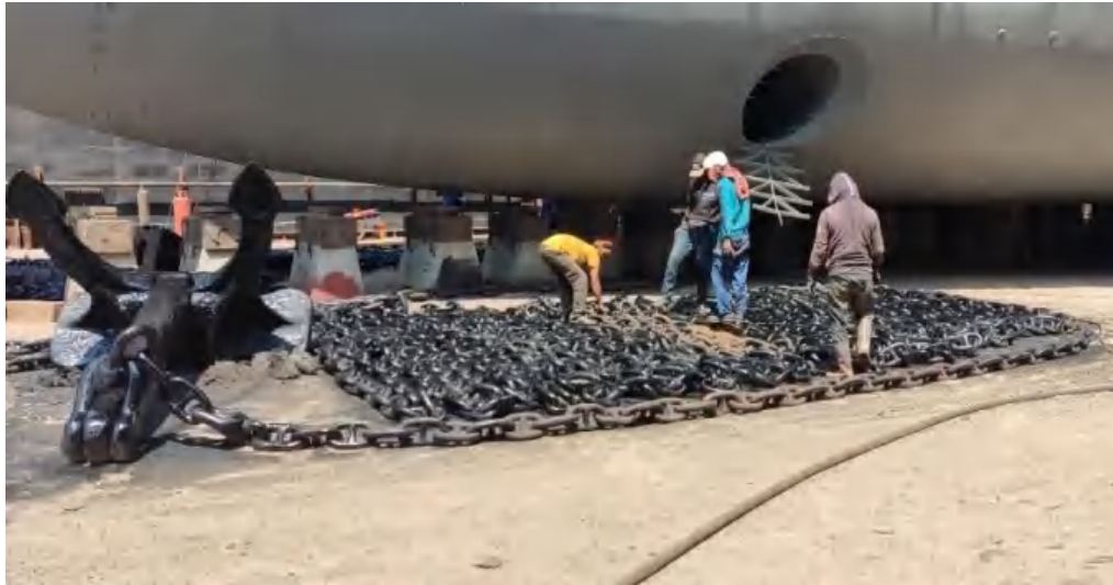
Gambar 10. Proses pengecatan pada rantai jangkar sebagai salah satu proses perawatan rantai jangkar
