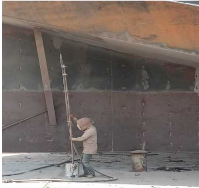
Gambar 2 Sandblasting Sumber : Dokumentasi pribadi
