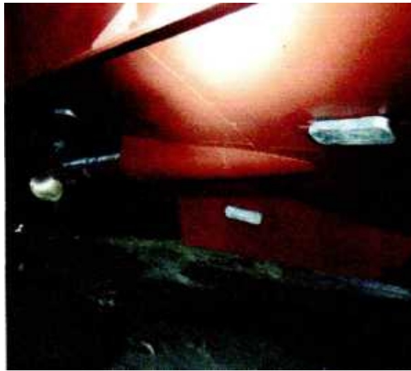
Gambar 5 Pemasangan Zinc Anoda
