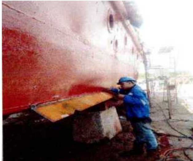
Gambar 14 Proses Fitup Plat Bilga Keel
