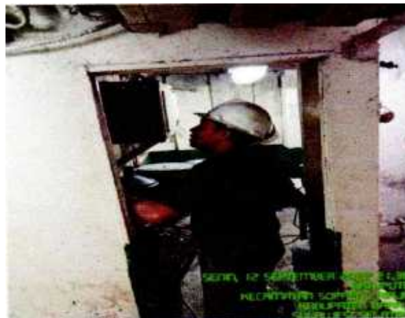
Gambar 21 Pekerjaan Instalasi Kelistrikan
