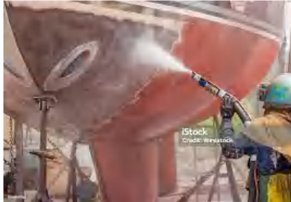
Gambar 3. Sandblasting lambung kapal
