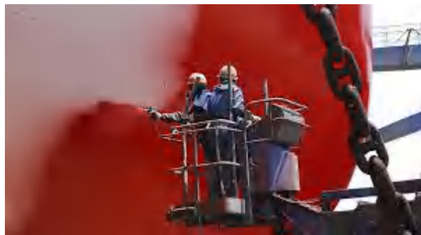
Gambar 4. Pengecatan lambung kapal
