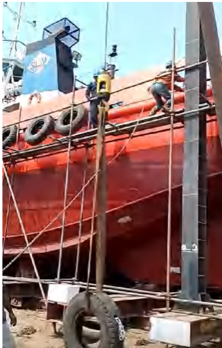
Proses pemasangan ban dapra
