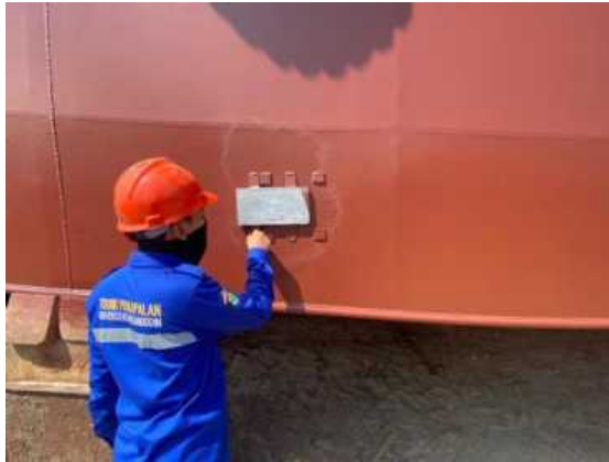
Gambar 9 zinc anode setelah dipasang pada kapal
