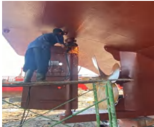
Gambar 8 pemasangan daun kemudi
