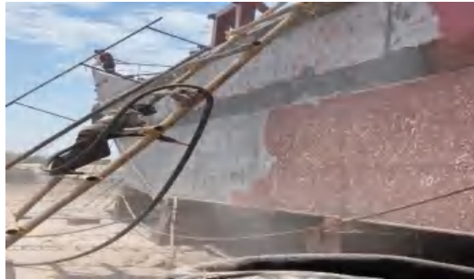
Gambar 3 Sandblasting lambung kapal
