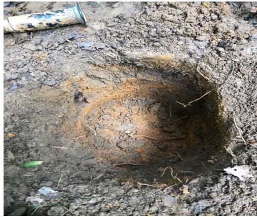
Lampiran 2. Galian lubang dengan diameter 30 cm dan kedalaman 40 cm
