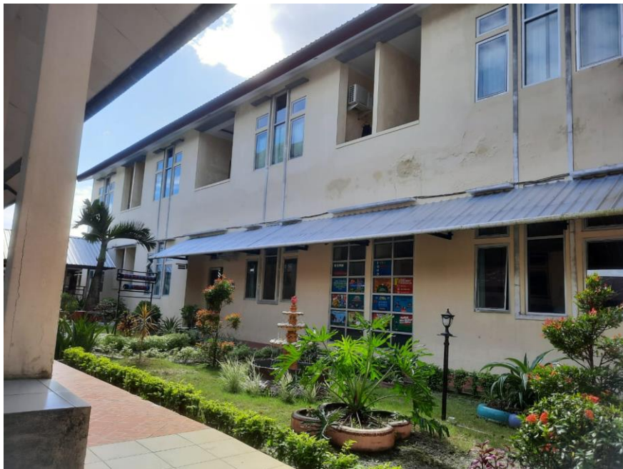
Gedung Balai Pelatihan Kesehatan Provinsi Maluku Sumber : Dokumen Profil Bapelkes
