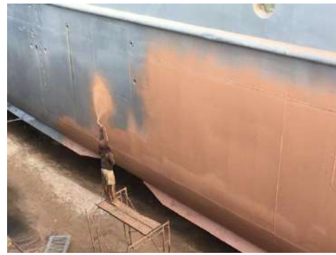
Pengecatan lapisan akhir AF ( Anti fouling )
