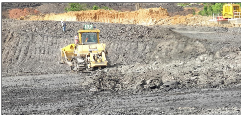
Gambar 2.12. Proses penggaruan di lapangan dengan Bulldozer
