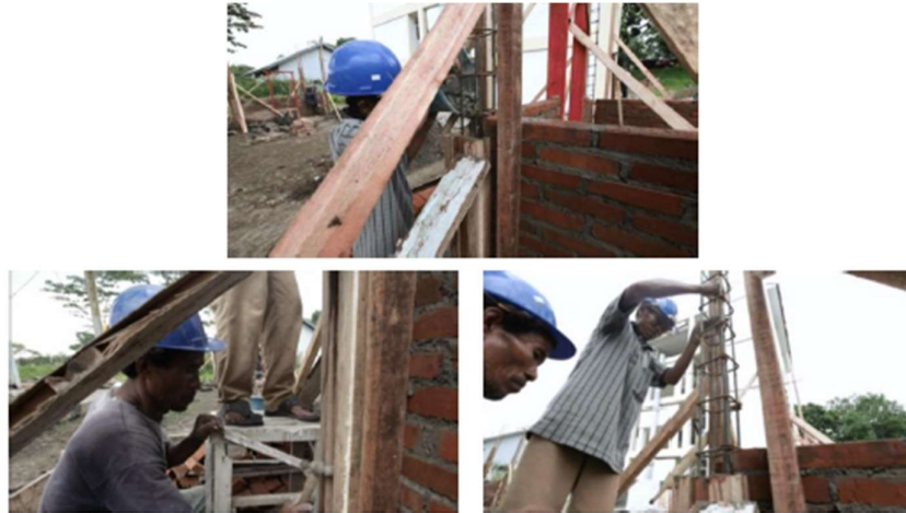
Gambar 29. Pemasangan beton dengan memukul-mukul cetakan/bekisting dan campuran beton dirojok menggunakan besi atau bambu
