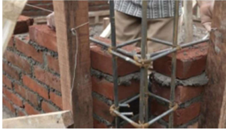
Gambar 24. Pemasangan ankur besi sebagai pengikat antara kolom dengan dinding pada sudut bangunan
