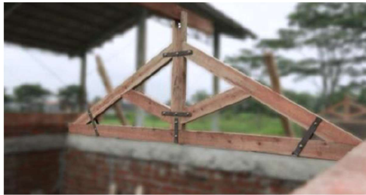
Gambar 8. Kuda-kuda kayu dengan pengikat plat baja
