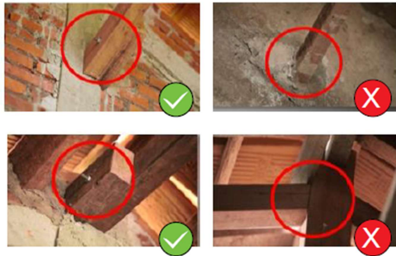
Gambar 15. Detail aertemuan antara ikatan angin dengan gunung-gunung/ampig
