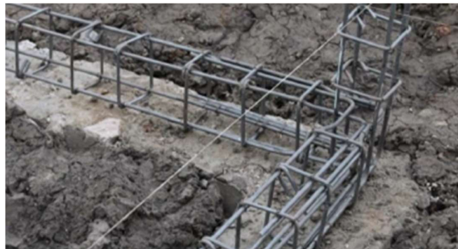
Gambar 21. Hubungan antara balok pengikat/sloof dengan tulangan kolom
