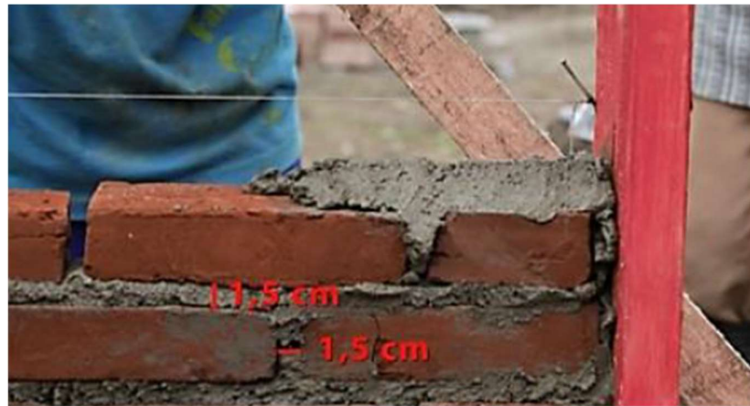
Gambar 18. Proses pemasangan batu bara untuk dinding
