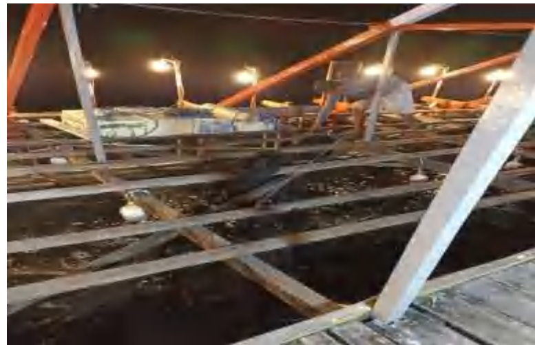
Proses penurunan jaring
