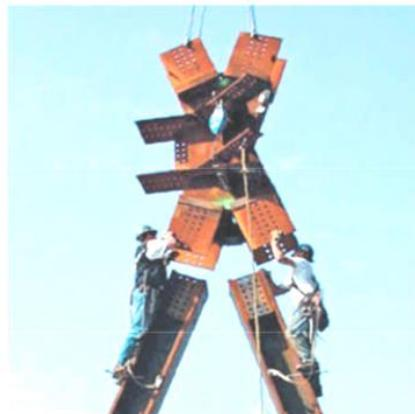
Gambar 14 Proses pemasangan prefabrikasi Nodes pada Hearst Tower
