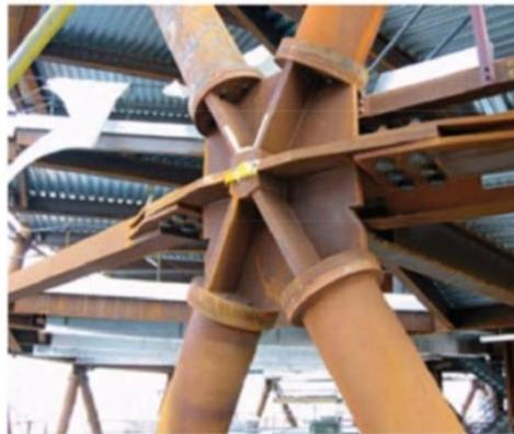
**Gambar 13** prefabricated nodes pada Swiss Re Tower
