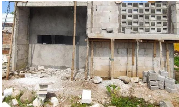
Gambar 30. pekerjaan rumah sederhana di Perumahan Al Fath Barombong
