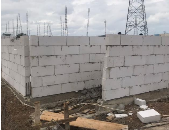
Gambar 31. Pekerjaan dinding bata ringan di Perumahan Desa Hijau 2 Barombong
