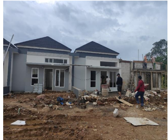
Gambar 24. Pekerjaan rumah tipe 36 Fatih Residence
