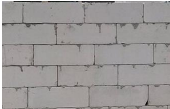
Gambar 29. Pasangan dinding bata ringan rumah tipe 30 di Perumahan Al Fath Barombong
