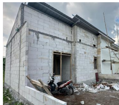
Gambar 34. Pekerjaan rumah tipe 36 di Perumahan Je'nemadinging Regency
