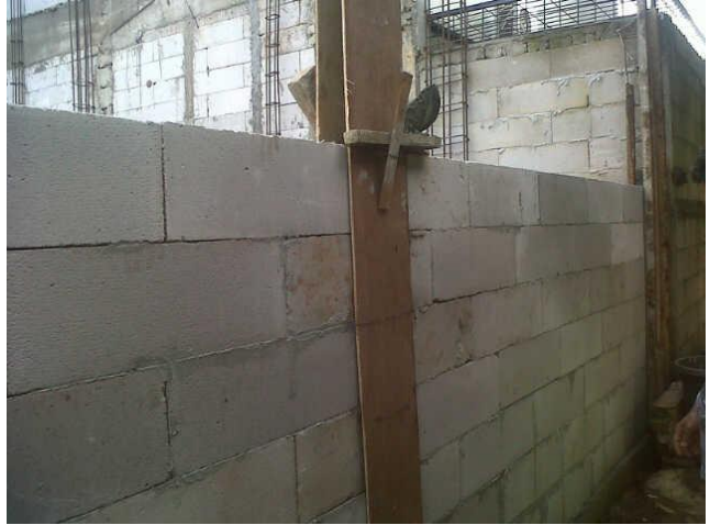
Gambar 28. Pasangan dinding bata ringan rumah tipe 30 di Perumahan Al Fath Land
