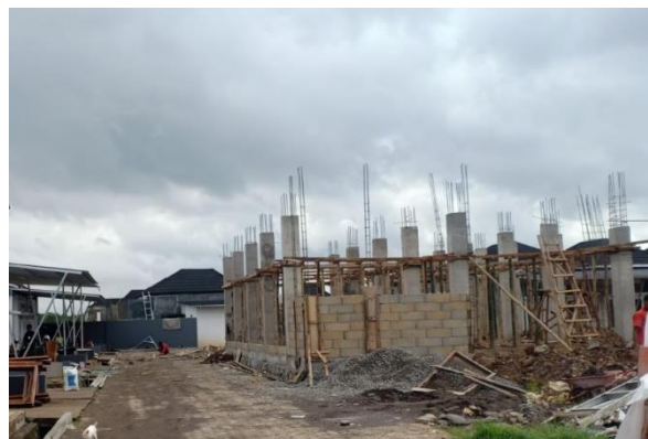
Gambar 26. Pekerjaan dinding bata ringan rumah tipe 36 di Perumahan Fatih Residence
