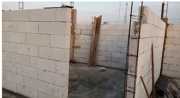
Gambar 25. Pasangan dinding bata ringan rumah tipe 36 di Perumahan Fatih Residence
