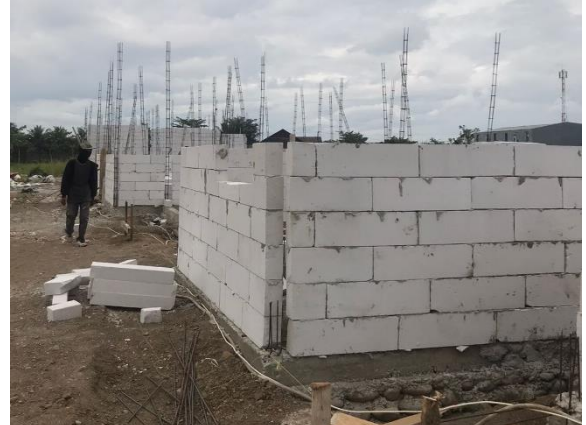
Gambar 32. Pekerjaan dinding bata ringan di Perumahan Desa Hijau 2 Barombong
