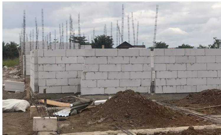
Gambar 33. Pekerjaan dinding bata ringan di Perumahan Desa Hijau 2 Barombong
