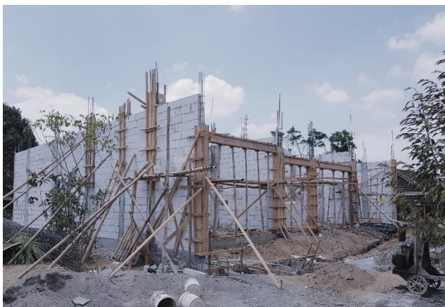
Gambar 34. Pekerjaan dinding bata ringan di Perumahan Royal Mas Residence
