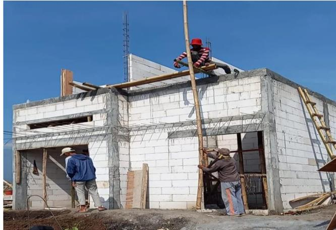
Gambar 3. Pekerjaan Dinding Bata Ringan
