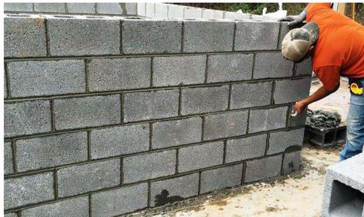
Gambar 2. Pekerjaan dinding batako
