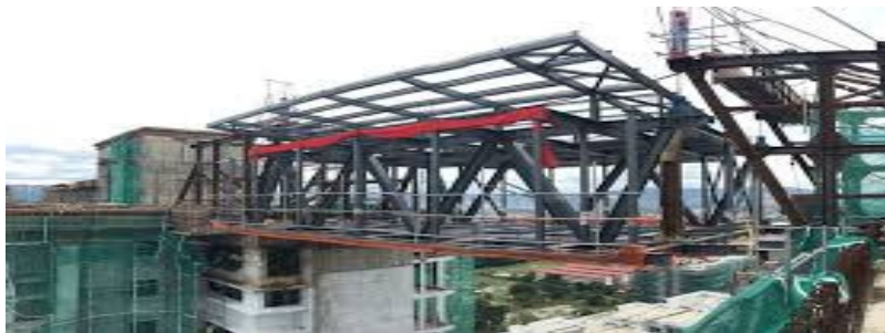
Gambar 2.8 Truss Skybridge Pada Sunway Velocity Residence, Kuala Lumpur Malaysia
