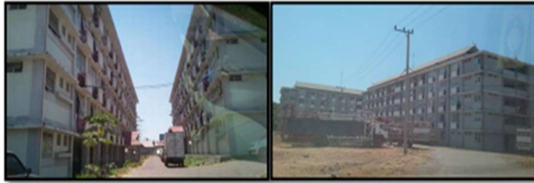
Gambar 1.1 Rusunawa Kima di Jalan Kima 10
