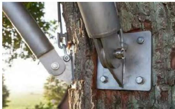
Gambar 8 Contoh Sistem Struts Untuk Menyebarkan Beban Platform
