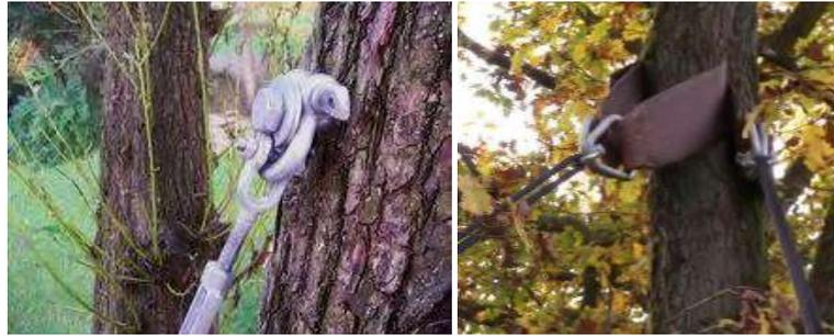
Gambar 10 Contoh Sistem Stay Rods Pada Rumah Pohon
