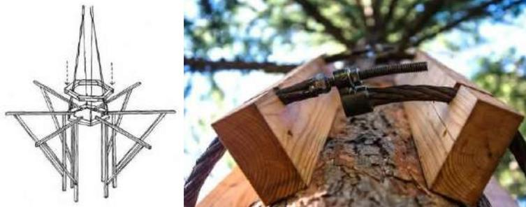
Gambar 11 Contoh Sistem Friction Pada Rumah Pohon
