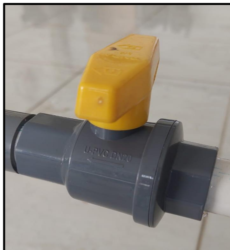
Gambar 35 Katup bola ( ball valve )
