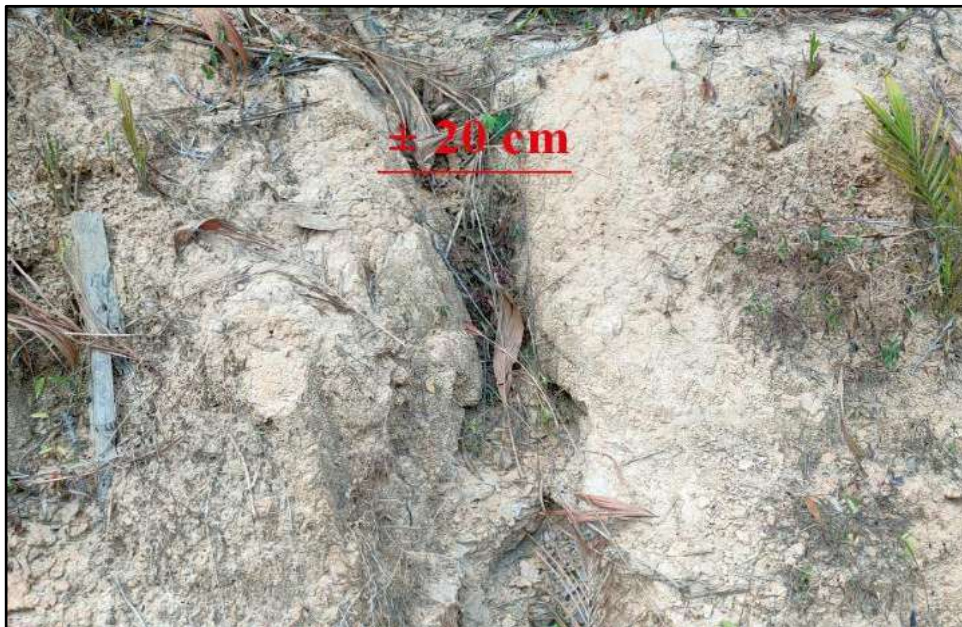
Gambar 17 Kenampakan Rill Erosion di daerah Onembute. Difoto ke arah N6°E
