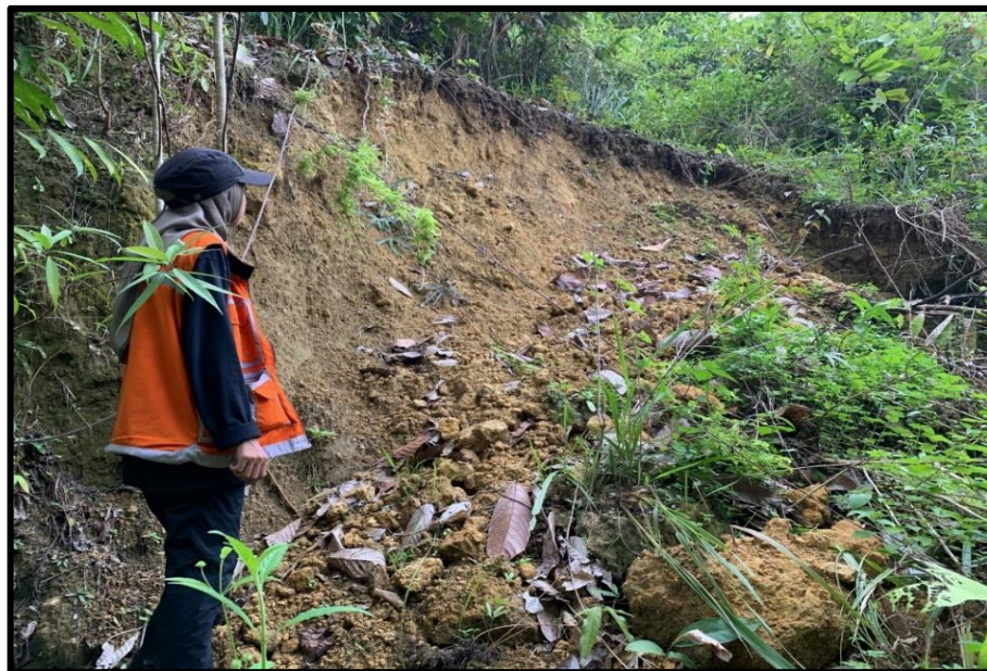
Gambar 24 Debris slide didekat stasiun 72 pada Desa Tangkowiwo dengan arah pengambilan foto N281°E.
