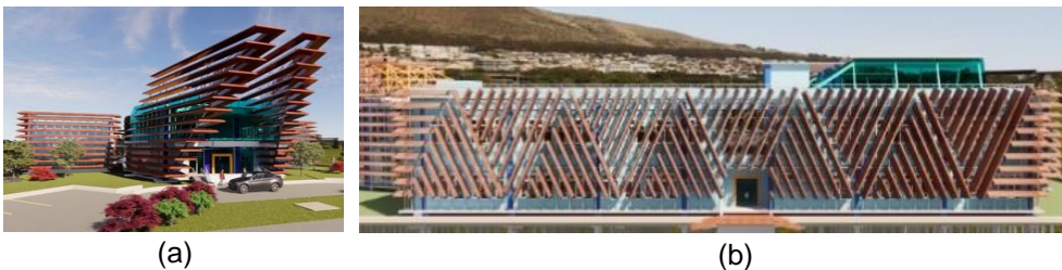
Gambar 3. Tampak depan (a) dan samping (b) gedung kuliah terpadu Polimarin
