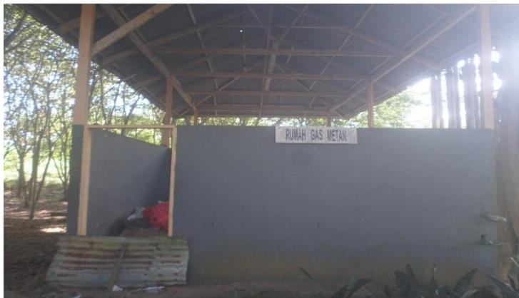
Gambar 11. Kondisi Rumah Gas Metan di TPA Rumbune
