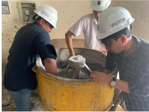
4. Pencampuran menggunakan *mixer* dilanjutkan selam 60 detik hingga didapatkan kombinasi campuran beton segar yang merata
