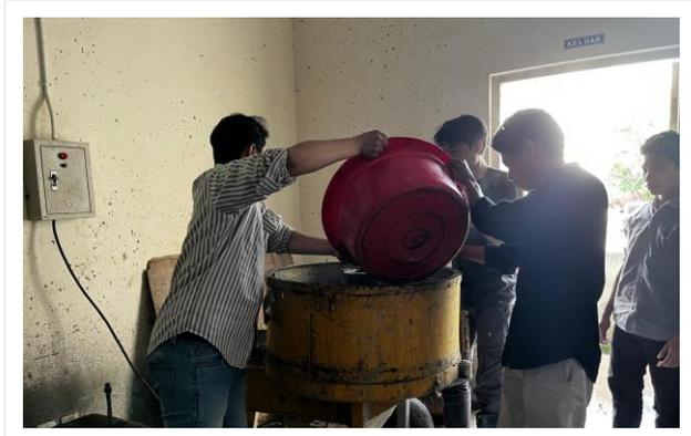
2. Selanjutnya, air yang telah dicampur dengan SP ditambahkan secara bertahap ke dalam *mixer*, dan pencampuran dilanjutkan selama 120 detik.
