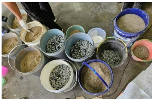
Lampiran 4. Persiapan material untuk pengecoran beton geopolimer
