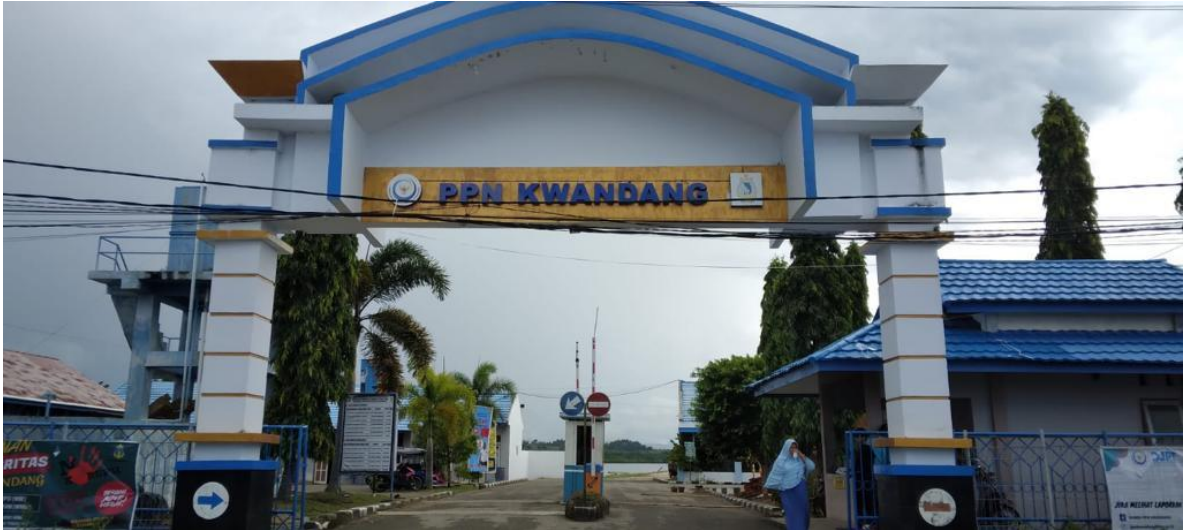
Tampak depan pintu gerbang PPN Kwandang
