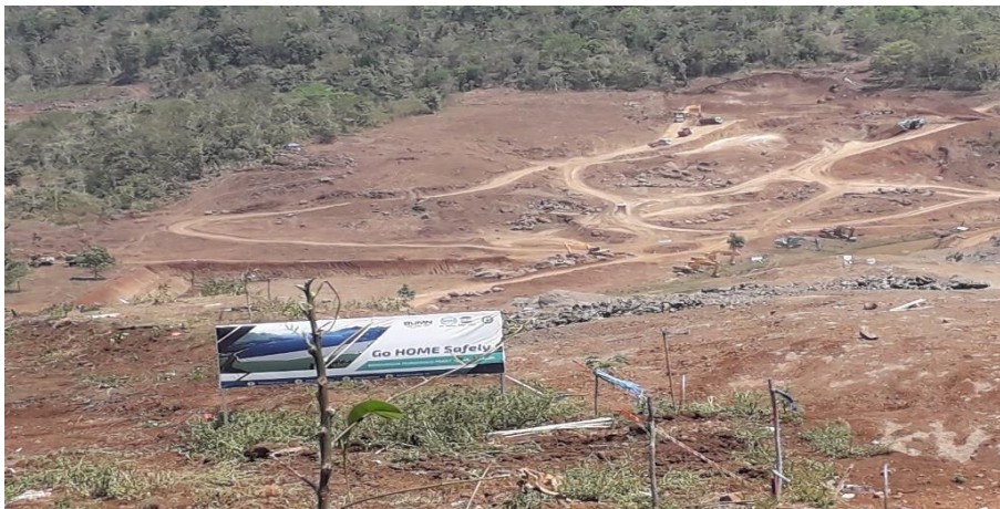
Lokasi Pembangunan Bendungan Pammukkulu
