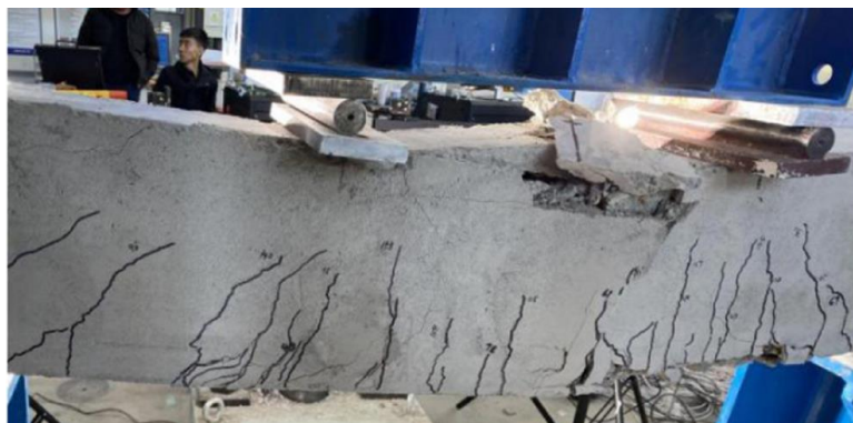
Gambar 2. Kegagalan benda uji pada balok beton dengan ankur pada wiremesh
