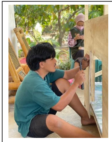
Gambar 26. Pemasangan Dinding Alat.
