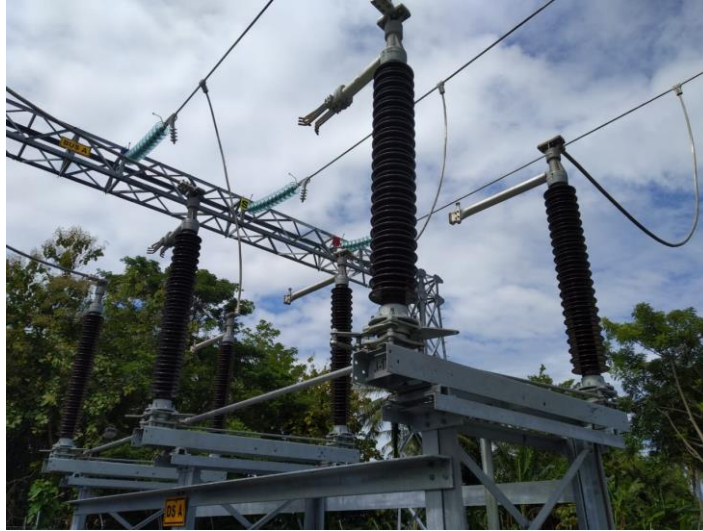
Gambar 2.6 Seperangkat PMS pada switchyard gardu induk Sumber: dokumentasi penulis
