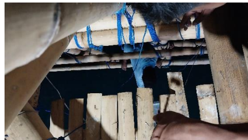
Pengukuran intensitas cahaya keseluruhan lampu bagian depan
