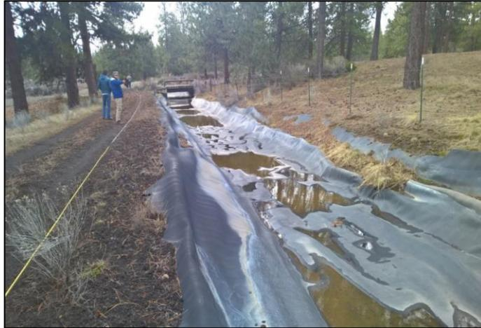
Gambar 3. Kondisi pemasangan material geomembran tipe *HDPE* pada Saluran Arnold, ruas pengujian A-3 (USBR, 2019)
