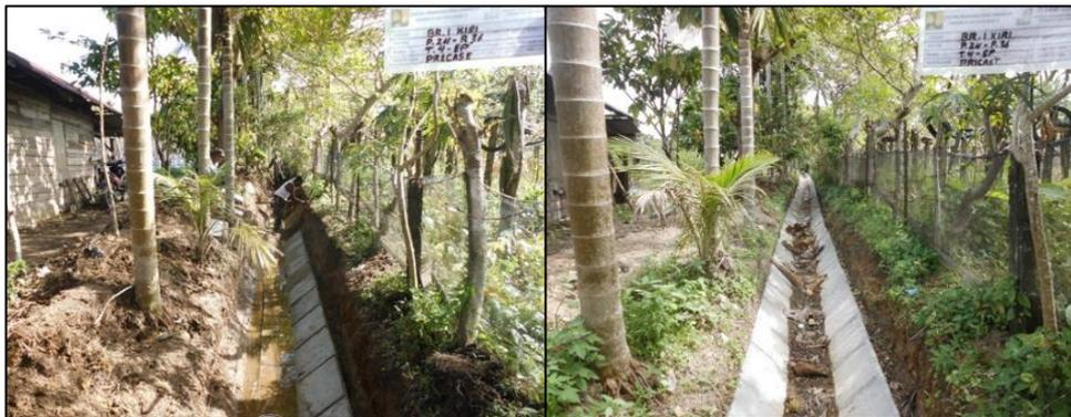
Gambar 10. Foto dokumentasi contoh kondisi trase saluran tersier yang melewati kawasan permukiman dan penggunaan pasangan (*lining*) di saluran irigasi tersier dengan menggunakan pasangan beton pracetak (pada dasar dan dinding saluran)
