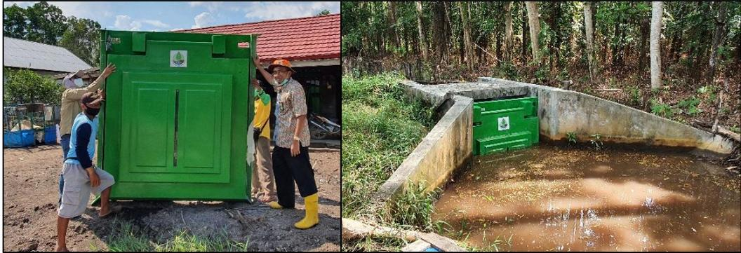
Gambar 20. Contoh produk pintu klep *GFRP* yang dipasang pada sistem bangunan air di saluran rawa di Desa Talio Hulu, Kecamatan Pandih Batu, Kabupaten Pulang Pisau, Provinsi Kalimantan Tengah
