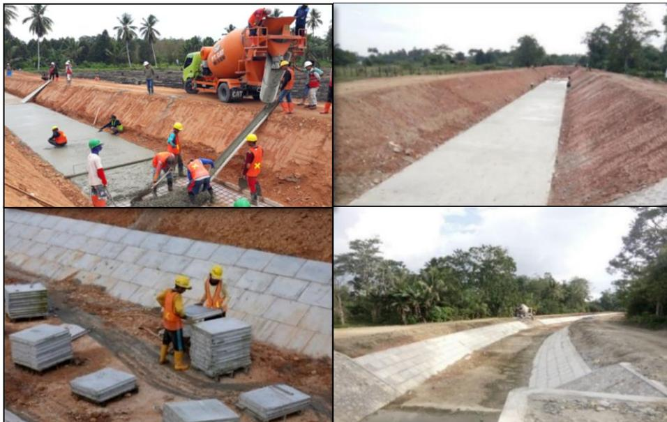
Gambar 2. Contoh penggunaan pasangan (*lining*) pada saluran irigasi dengan menggunakan pasangan beton cor ditempat (*cast in situ*, pada dasar saluran) dan beton pracetak (*precast*, pada dinding saluran)
