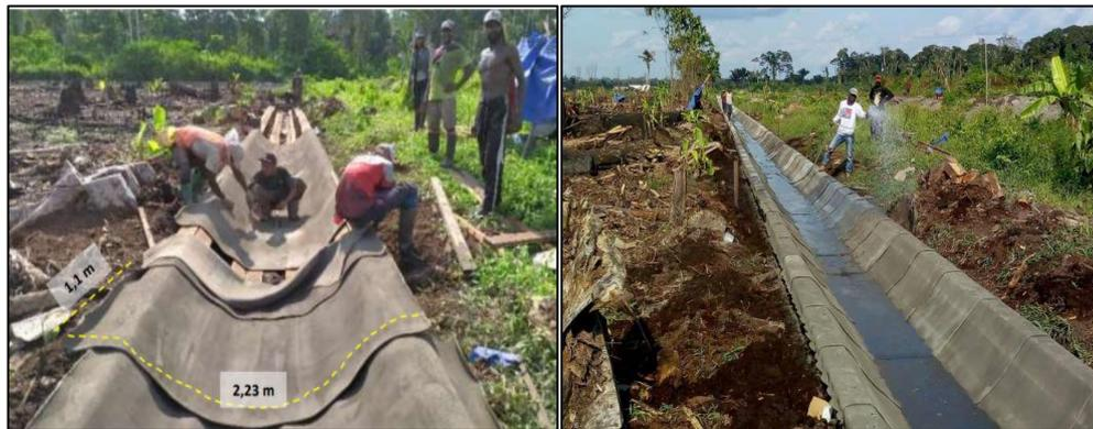
Gambar 12. Penerapan pasangan (*lining*) di saluran irigasi rawa dengan menggunakan pasangan kanvas beton (Puslitbang Sumber Daya Air, 2019)
