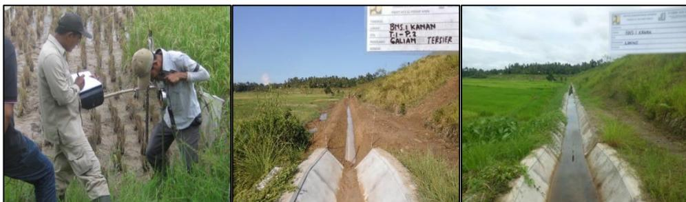
Gambar 9. Pengambilan sampel tanah dan penggunaan pasangan (*lining*) di saluran irigasi tersier dengan menggunakan pasangan beton pracetak (pada dasar dan dinding saluran)
