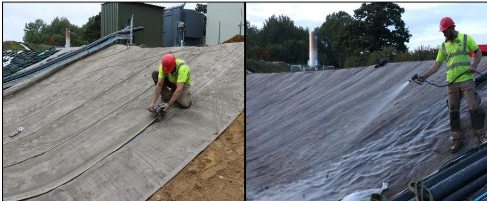
Gambar 11. Penggunaan teknologi kanvas beton tipe CC Hydro <sup>TM</sup> sebagai pasangan (*lining*) di dinding saluran (Concrete Canvas <sup>®</sup>)
