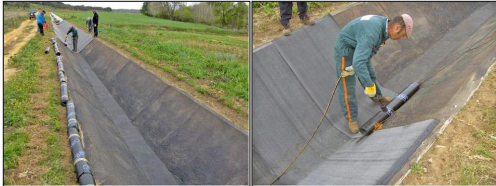
Gambar 4. Pemasangan membran bitumen di atas lapisan aspal primer dan penggunaan *blowtorch* untuk merekatkan bidang antar sambungan (Morgado, F. et al., 2016)
