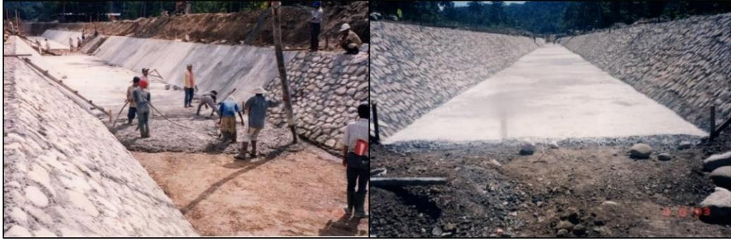
Gambar 1. Contoh penggunaan pasangan (*lining*) di saluran irigasi dengan menggunakan pasangan kombinasi berupa beton cor di tempat (*cast in situ*, pada dasar saluran) dan pasangan batu (pada dinding saluran)
