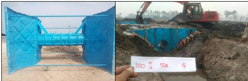
Gambar 18. Contoh produk gorong-gorong dan pintu klep *GFRP* yang dipasang pada sistem saluran irigasi rawa di Desa Jungkal, Kecamatan Pampangan, Kabupaten Ogan Komering Ilir, Provinsi Sumatera Selatan pada tahun 2019
