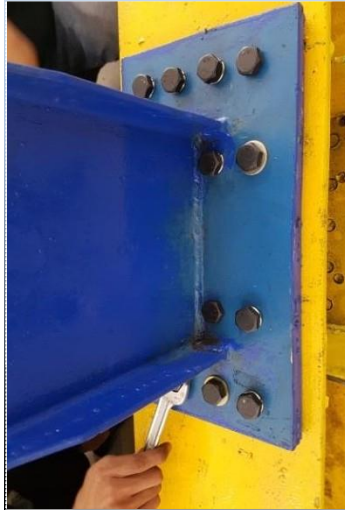
Gambar 2.6 Sambungan End Plate bangunan Tahan Gempa (Nini, 2018)
